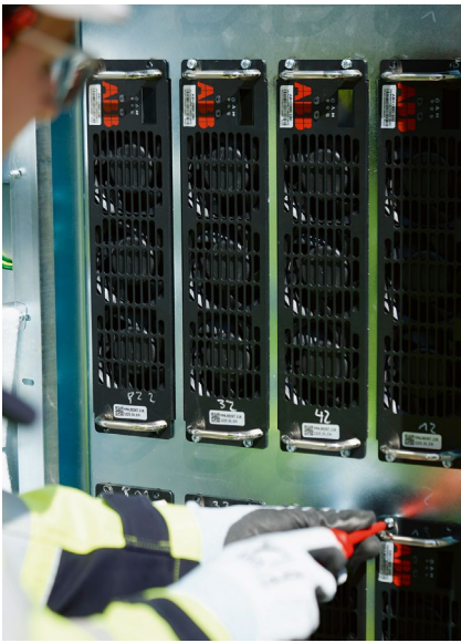
Der Ausbau von Ladesäulen läuft, aber es gibt noch was zu verbessern.
